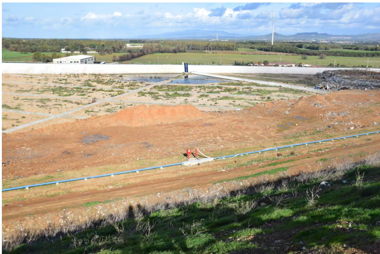
RETE ANTINCENDIO E RETE CONVOGLIAMENTO PERCOLATO DEL SEMI BACINO 2 DEL MODULO 3
