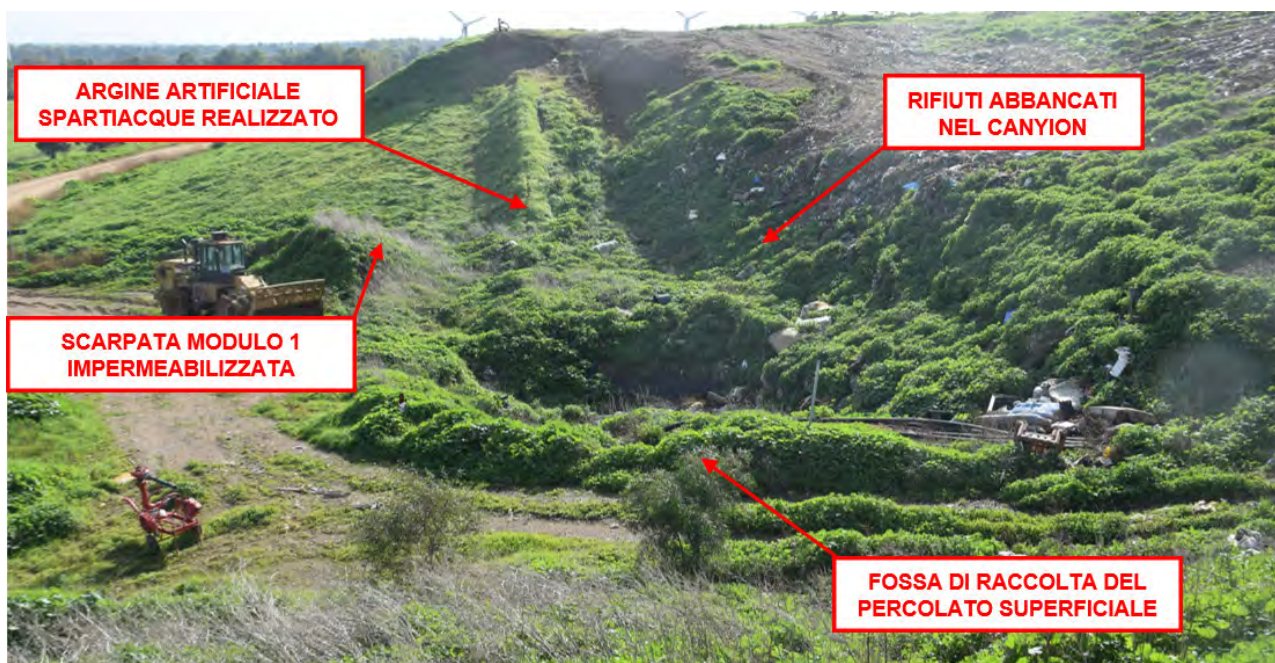
DETTAGLIO 1 CON VISTA DELL'ARGINE POSTO NELLA PARTE TERMINALE DEL CANYON
